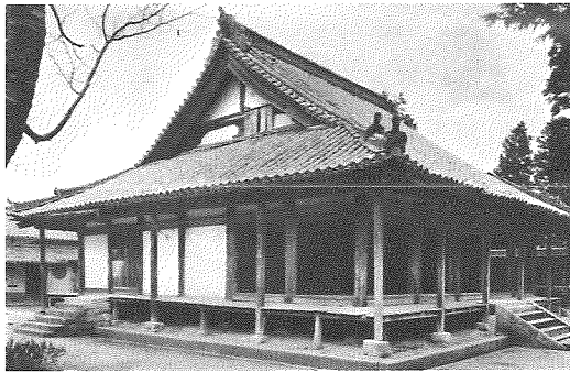
図-2 円光寺本堂 正側面全景 修理前
