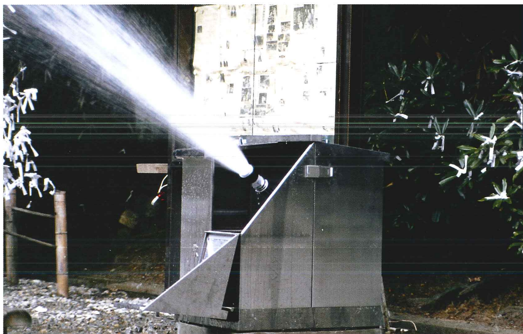
写真Ⅱ 一斉開放型放水銃
