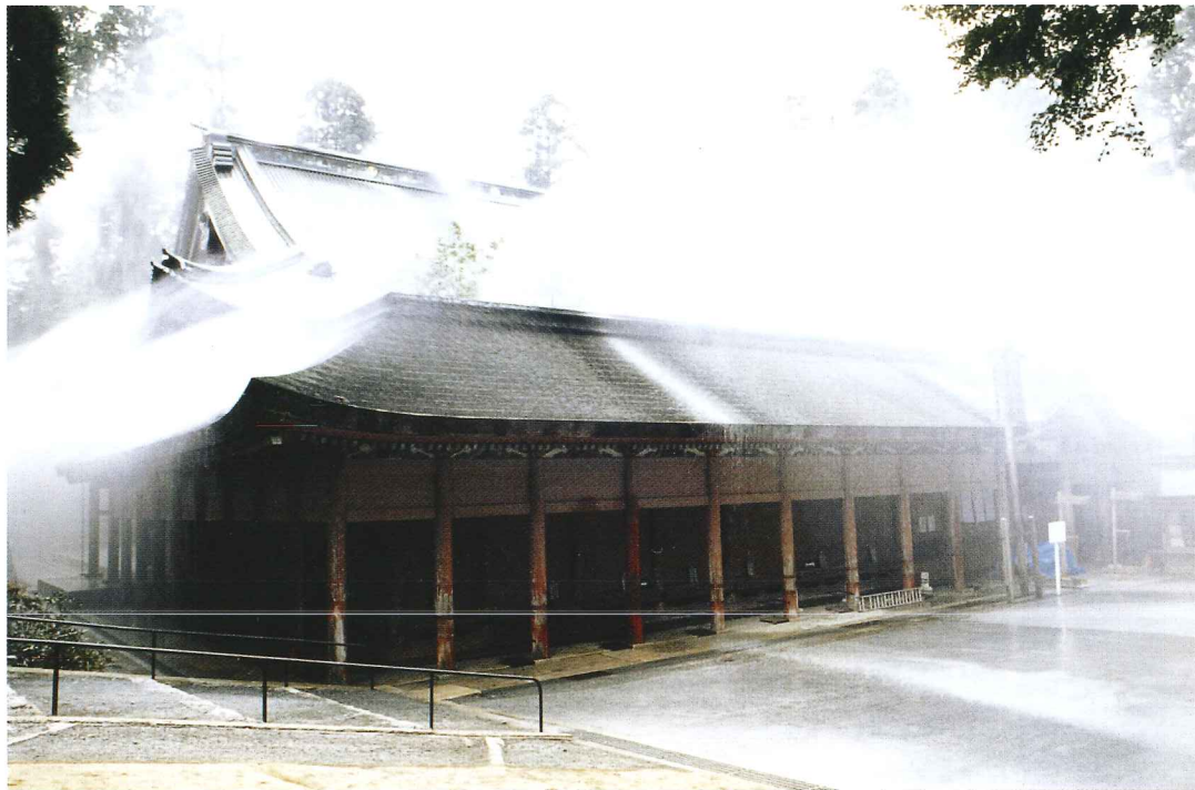
写真Ⅰ 延暦寺根本中堂の放水状況
