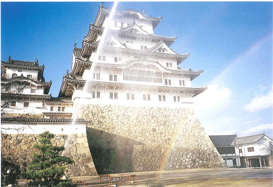
口絵2 姫路城天守閣への放水状況
