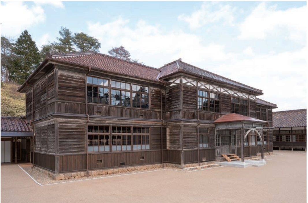
口絵 2 旧吹屋小学校校舎 本館 全景
