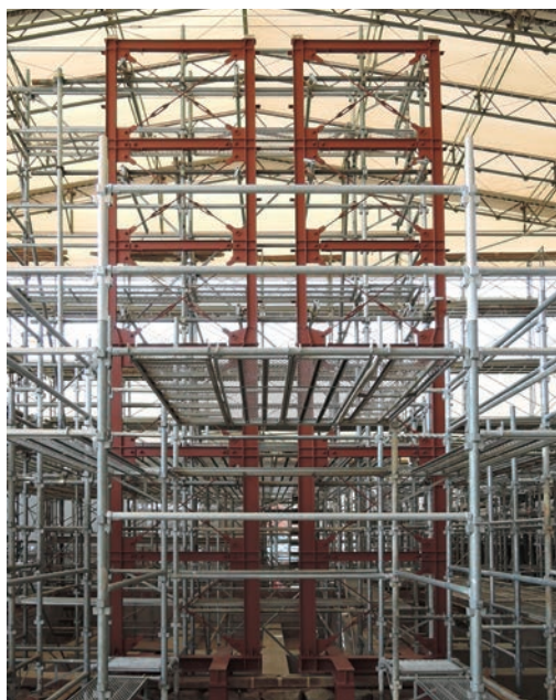
写真13 本館 鉄骨フレーム組立完了
