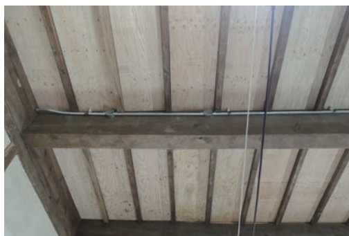
写真12 本館 2階床板下水平構面補強
