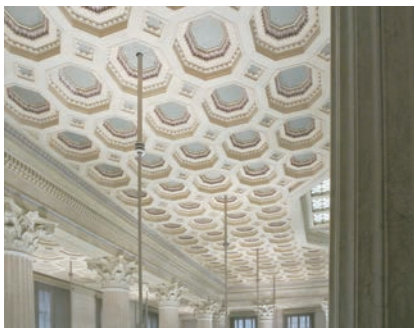
図6 旧三井銀行大阪支店営業室天井廻り
