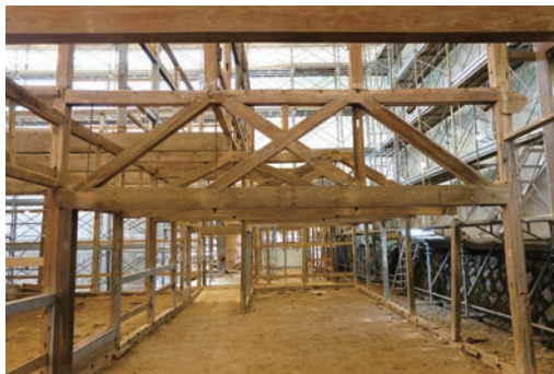
写真5 本館 屋内運動場の小屋組 (平行弦トラス)
