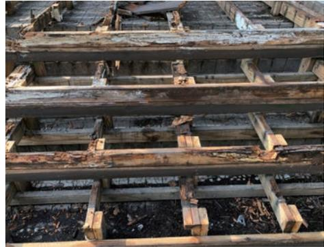
写真13-5 屋外階段の下地材の腐朽
