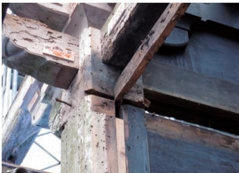
図15 外陣 変更前(板決りに埋木し、嵌め殺し菱格子を入れていた。板壁に菱格子に復旧)
