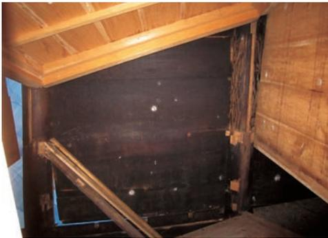
図5 破損状況 内陣（天井、床が外れている。）
