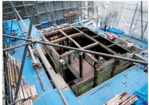
図6 破損状況（手前の柱上部と梁の折損）
