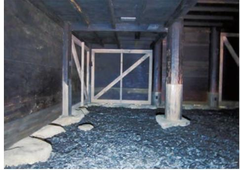
図21 構造補強 床下筋違
