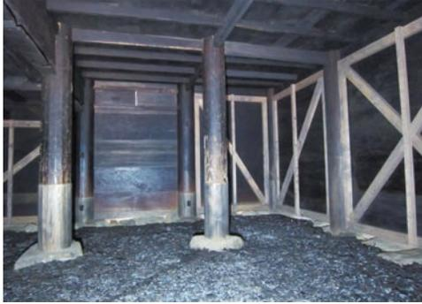
図20 構造補強 床下筋違
