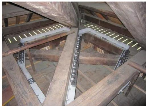
図3.6 小屋裏、鋼製筋違の設置
