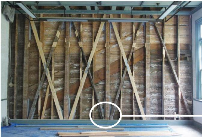
図3.9 筋違及び筋違端部金具設置状況
