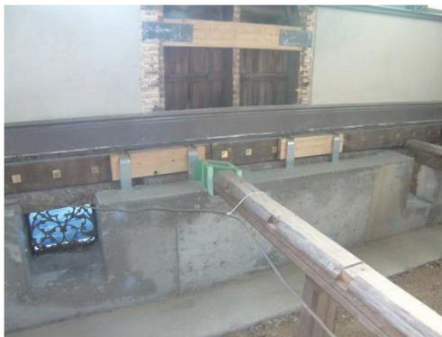
図3.5 基礎梁、付土台の設置
