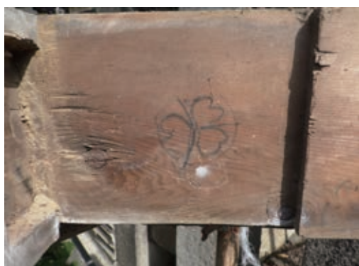
写真22 築地塀桁継手の合番付（葵紋）
