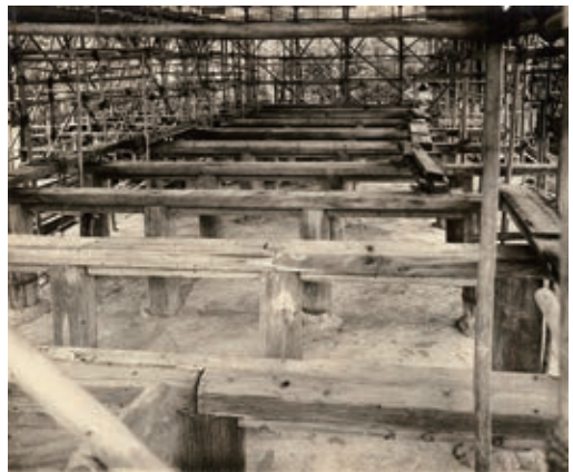
写真2 正倉解体修理の様子 組立時
