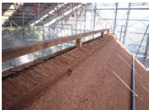
写真17 施工中 檜皮施工状況
