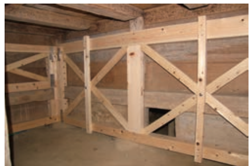
写真13 身舎床下 構造補強材取付
