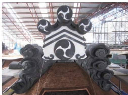
写真18 施工中 獅子口据え付け状況
