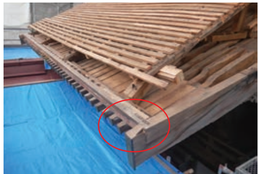
写真16 破風板及び破風板木口 (破風板木口上端が極端に前屈みになる)
