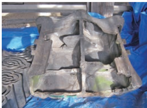
写真6 修理前 獅子口背面 箱棟を差し込む部分に合わせて 割られたリブや背面の蓋
