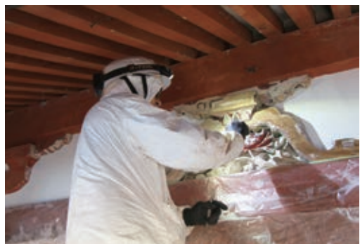
写真10 身舎正面幕股 彩色剥落止
