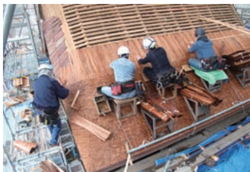
写真6 檜皮葺施工中 背面
