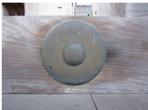
写真8 修理前 縁長押 箱押しの剥落
