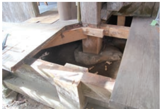
写真8 浜縁縁板の修理状況
