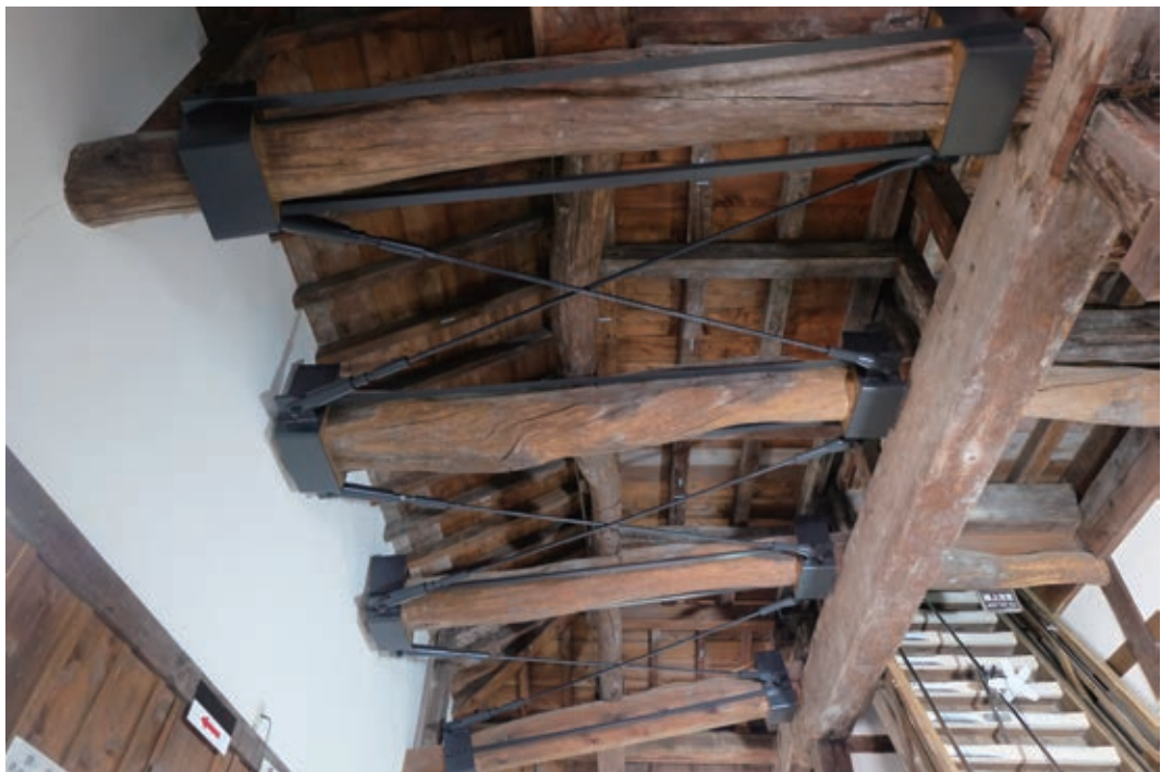
口絵 3 彦根城天守 1階東側 水平構面補強
