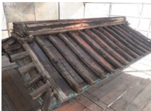
写真5 銅瓦葺の全面解体（唐門）
