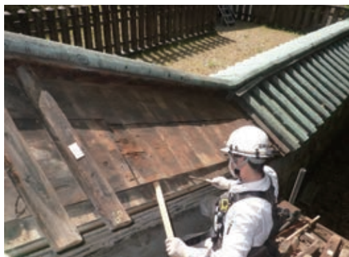
写真11 銅瓦葺解体（築地塀）
