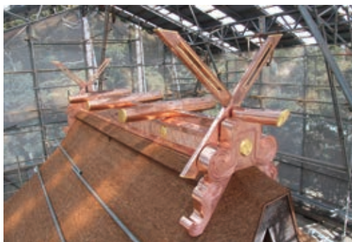
写真9 棟周りの銹金具および銅板
