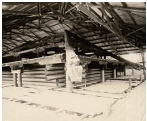
写真3 正倉解体修理の様子 旧屋根組
