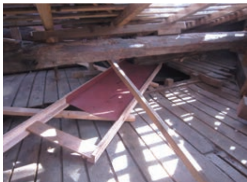
写真10 同前 小屋裏に銅製受け皿を設置
