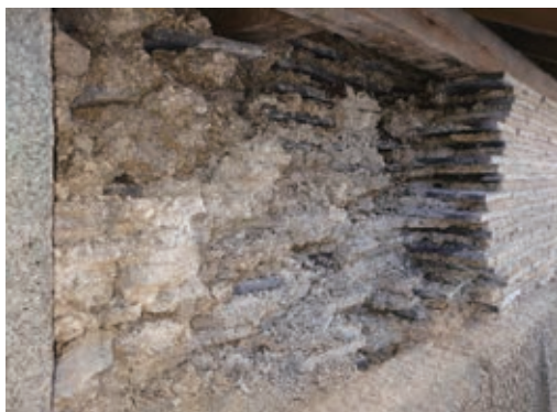
写真17 築地塀熨斗瓦積解体状況
