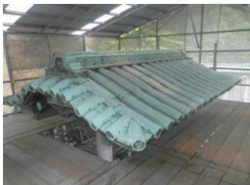
写真10 銅瓦葺屋根葺き直し完了（唐門）
