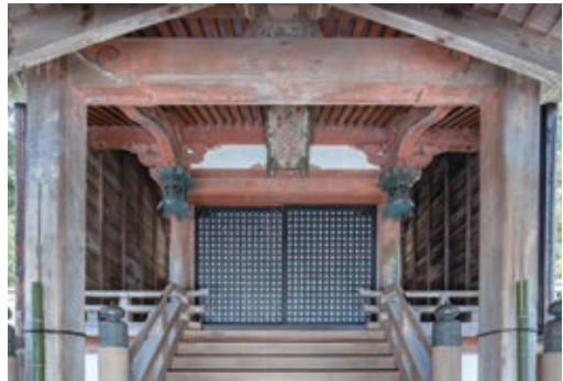
写真12 正面格子戸の防塵対策（パネル取付）
