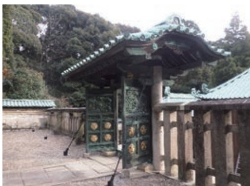
写真19 唐門及び左右石柵 転倒防止策
