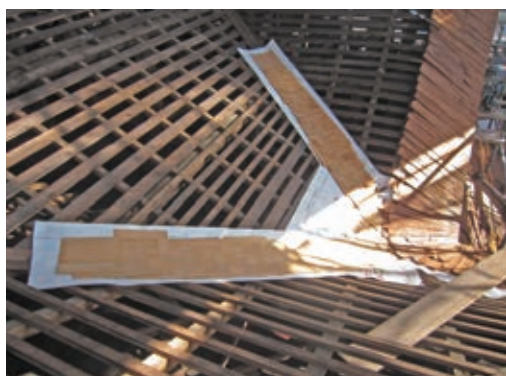
写真12 同前 施工状況 谷部の漏水対策範囲を広げ、 土居葺下にルーフィングを敷く
