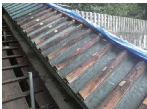
写真15 瓦棒、銅瓦葺の葺き直し（築地塀）
