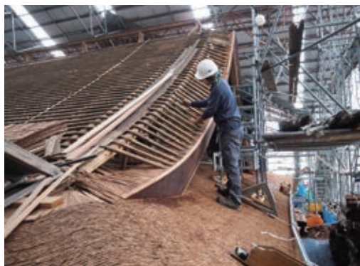
写真16 施工中 本殿 葺甲下地、櫛形板ではなく、 野木舞状の部材を葺甲上に掛ける
